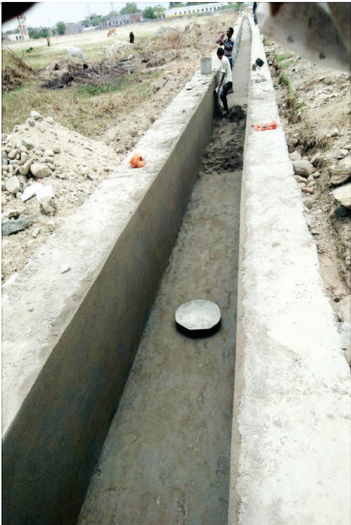
राज्यावास पंचायत मुख्यालय पर निर्माणाधीन नाली।
